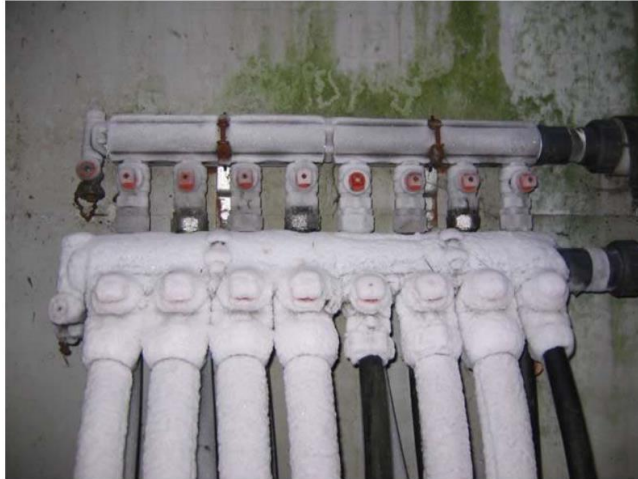
Quelle: Dokumentation von Schadensfällen bei Erdwärmesonden. Simone Bassetti, Ernst Rohner, Sarah Signorelli, Bernard Matthey. Energie Schweiz, 2006
