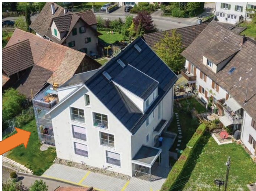
Immeuble d'habitation rénové à Oberengstringen. Installation PV de 31 kW couvrant 131% du besoin total en énergie. Prix Solaire Suisse 2015
