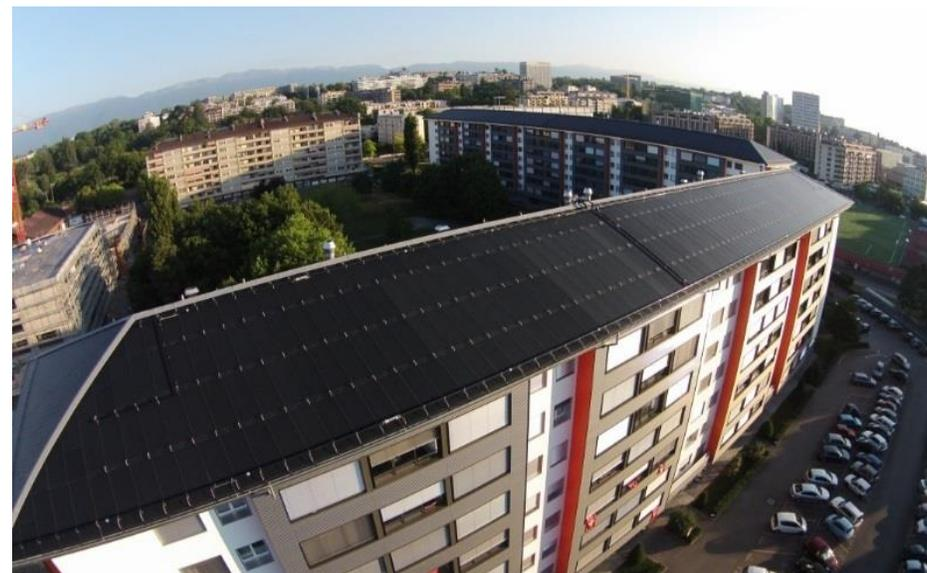
Immeuble d'habitation La Cigale, Genève, rénovation Minergie-P. 1670 m<sup>2</sup> de capteurs non vitrés couvrant 52% du besoin total en énergie. Prix Solaire Suisse 2014
