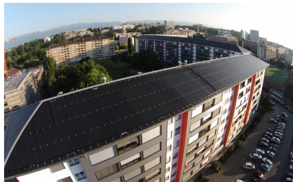
Immeuble d'habitation La Cigale, Genève, rénovation Minergie-P. 1670 m 2 de capteurs non vitrés couvrant 52% du besoin total en énergie. Prix Solaire Suisse 2014
