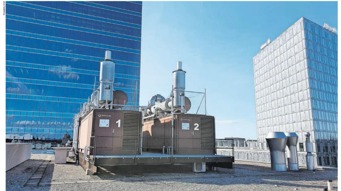
2 x 1 MW el auf einem Dach in ZH (als Notstromaggrat, photo Powerloop)
