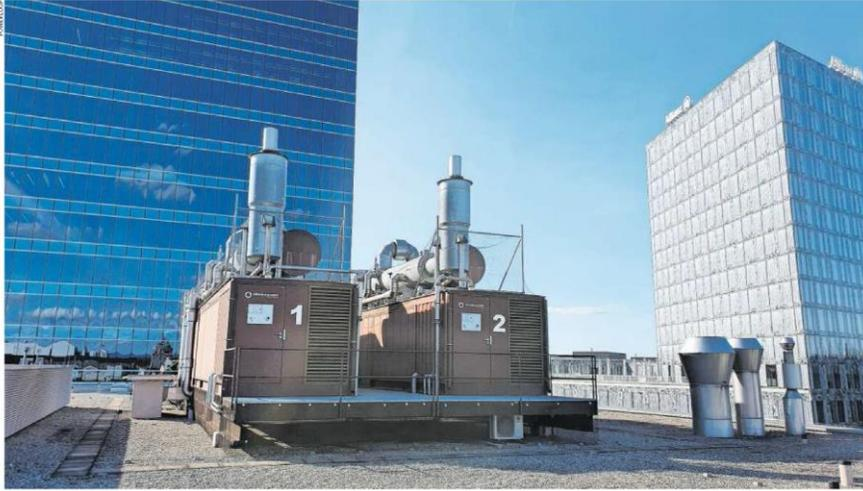
2 x 1 MW<sub>el</sub> sur un toit à ZH (ici une génératrice de secours, photo Powerloop.ch )
