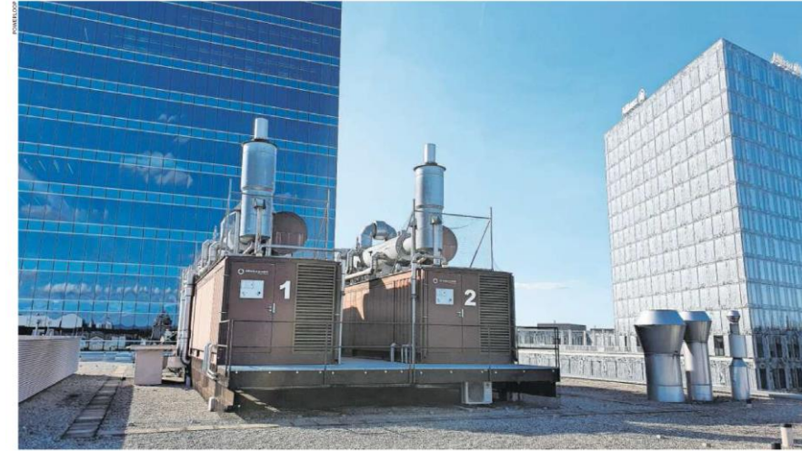
2 x 1 MW el auf einem Dach in ZH (als Notstromaggregat, photo Powerloop.ch )
